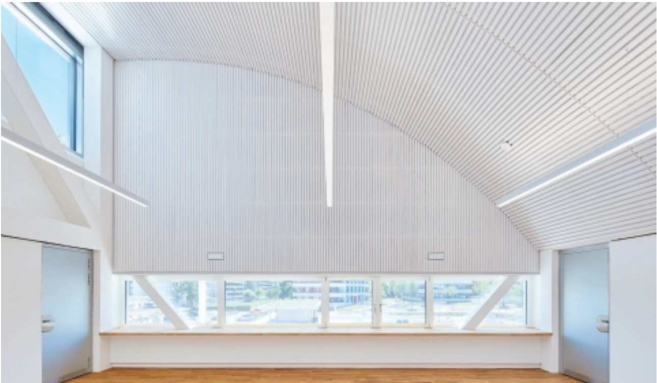
Schulzimmer Die Lichtbänder erzeugen ein gleichmässiges und blendfreies Licht. Entscheidend für die gleichmässige Ausleuchtung sind u.a. die Montagehöhe und die Abstände zwischen den Lichtbändern.
